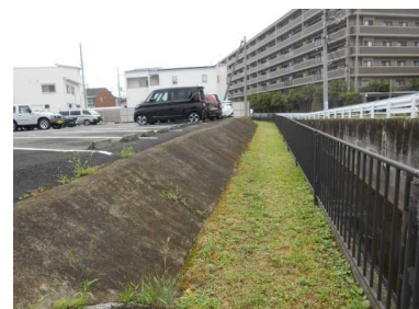
舗装されていない「里道」 （向こうに見えるマンションはレイクシティ）
