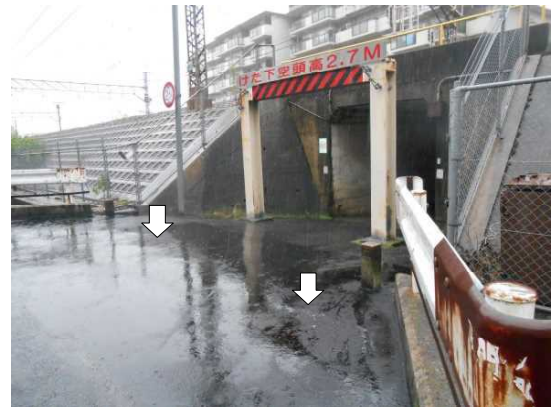
舗装後の状態
