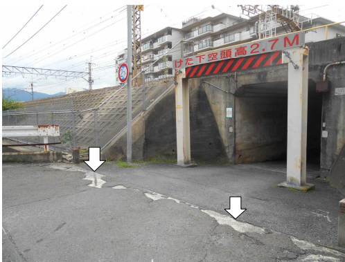
舗装前の状態
