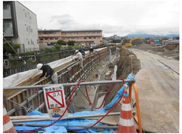
南側の擁壁工事の様子 (7月4日撮影)
